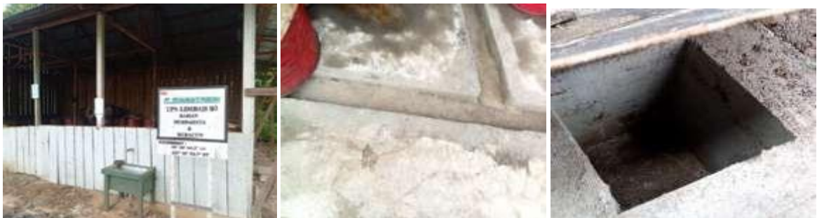
Gambar 8. Ruang penyimpanan Limbah B3 dan instalasi Oil trap
