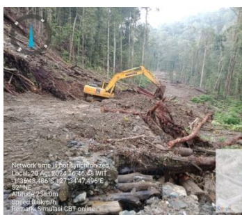
a. Pembuatan drainase jalan
