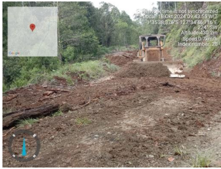
A. Pemeliharaan Jalan Cabang
