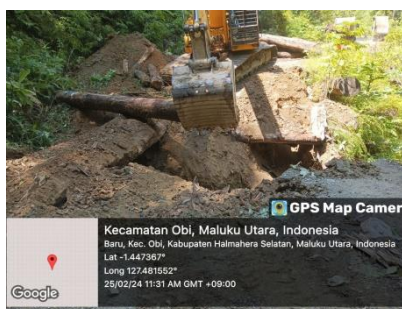
b. pembuatan bangunan jembatan
