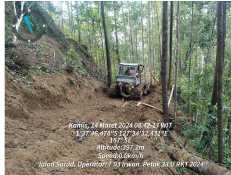
d. pembuatan Jalan Sarad
